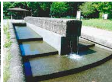
水源地の逆川緑地に復元された岩樋(いわひ)
